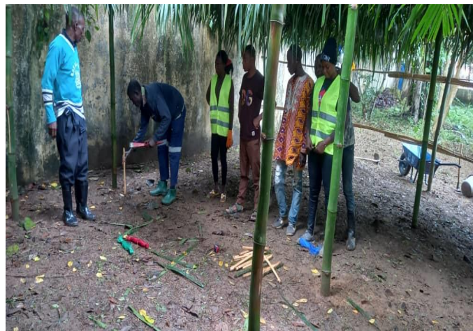
Figure 5: construction du hangar et traçage des planches
