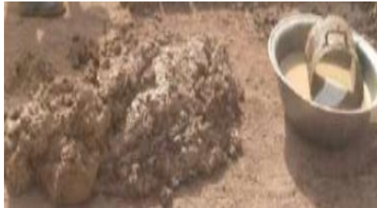
Figure 3: mélange de l'argile
