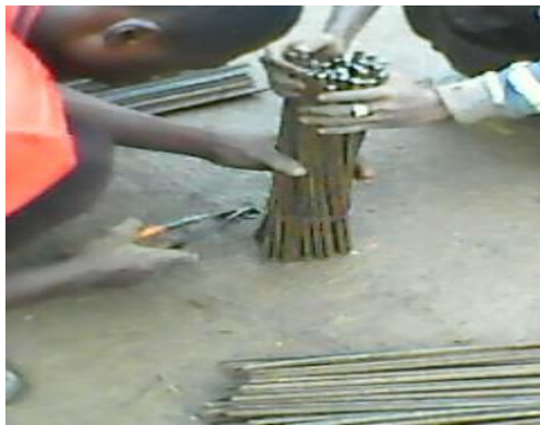
Figure 2: barres de fer découpé
