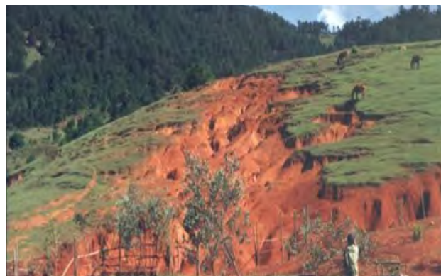
Glissement de terrain
